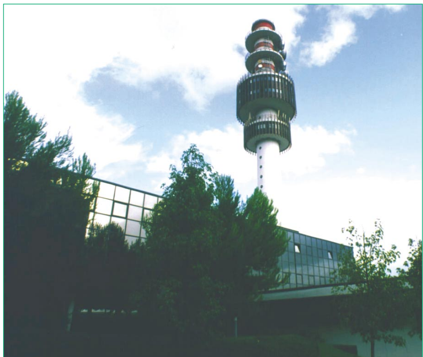
Foto 1 La torre radio del comprensorio Telecom Italia di via Oriolo Romano 257.
