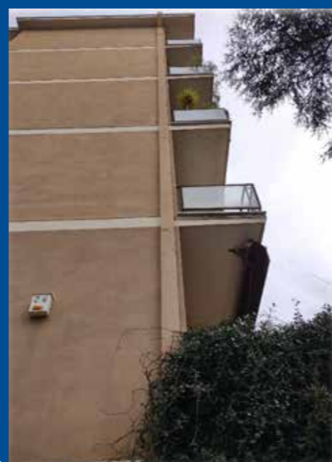
Figura D: Via Cassia - Posa Verticale di Fibra in condotta effetto muro
