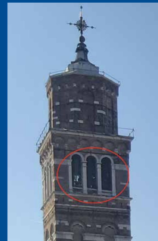
Figura E: Dettaglio cella campanaria con antenna al centro della trifora
