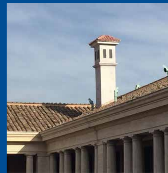
Figura F: Santa Maria in Trastevere Antenna camuffata in torretta appositamente realizzata
