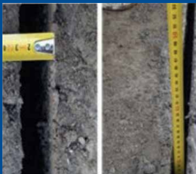
Figura C: Taglio minimale MicroTrincea, abbinato ad una profondità di 40/45 cm (superiore ai canonici 30cm)
