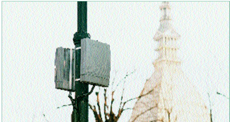
Figura 6 Torino. Installazione di due stazioni radio DECT Italtel su un palo di illuminazione stradale.
