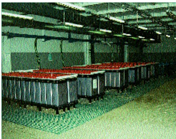
**Figura 6** *Installazione di batterie di accumulatori a piastre tubolari.*
