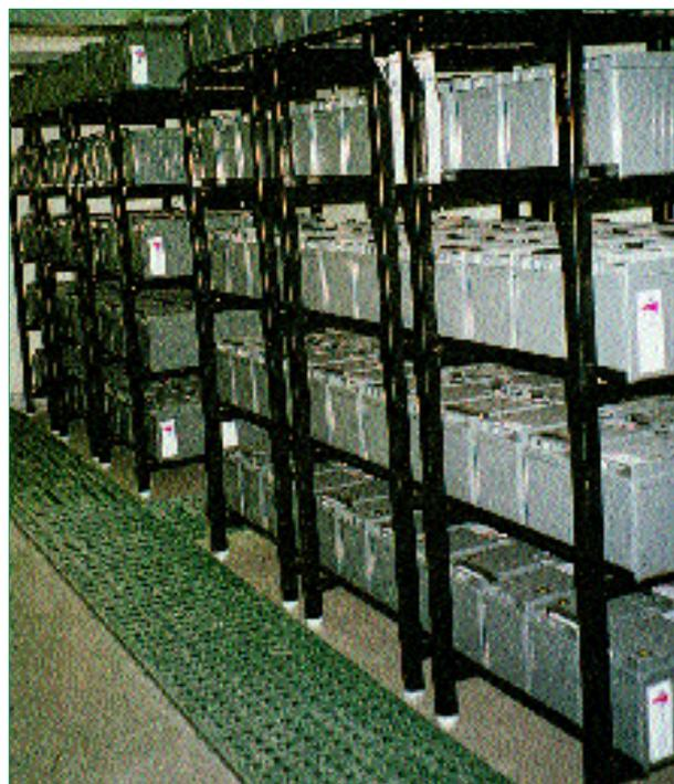
**Figura 7** *Installazione di batterie di accumulatori a tecnologia AGM.*
