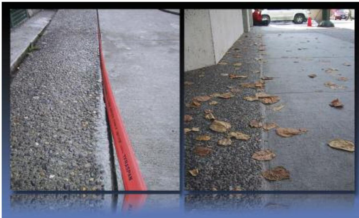
**Figura 6** - Posa di una canaletta con la tecnica della "minitrincea"
