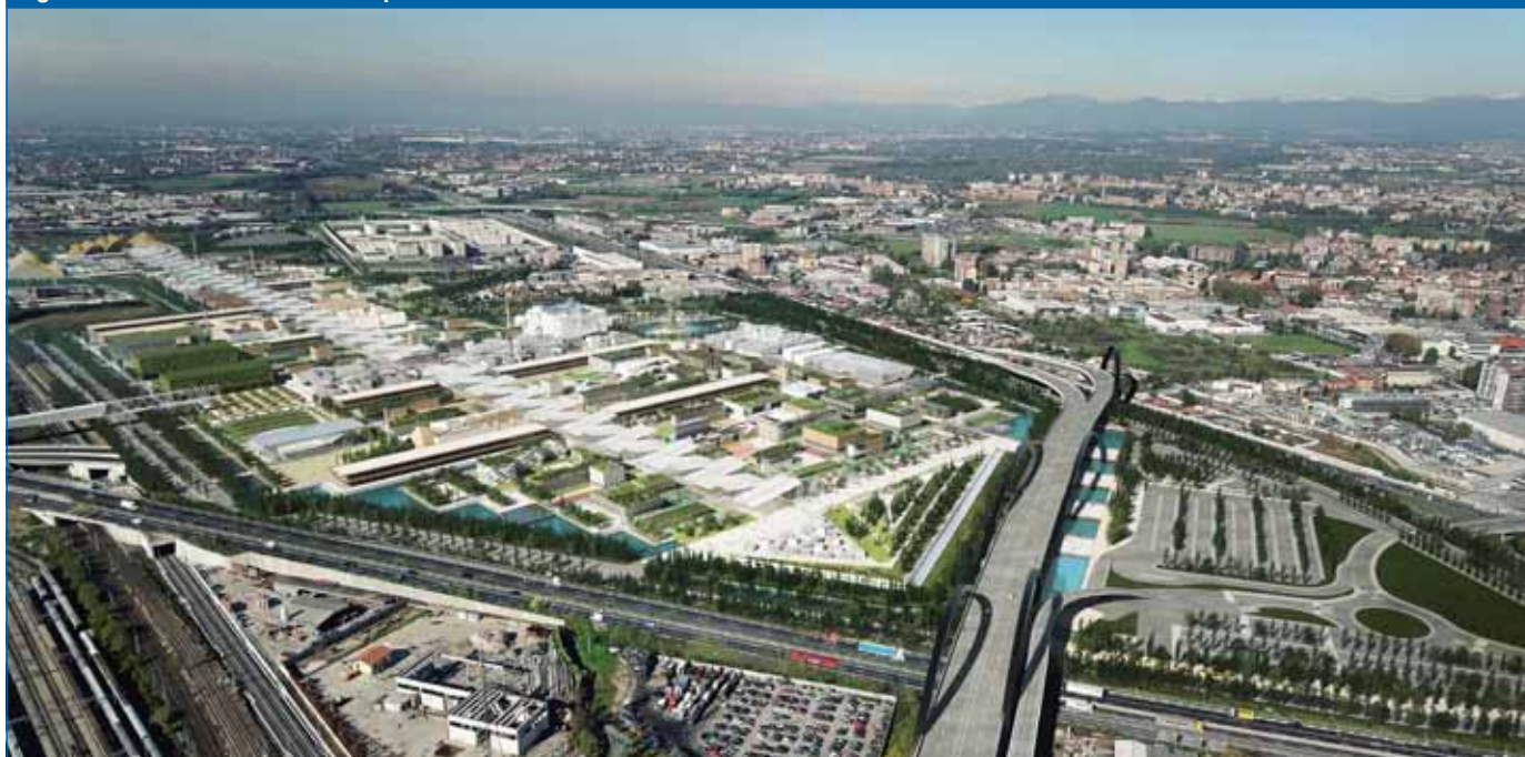
Figura 1 - Veduta aerea del sito espositivo
