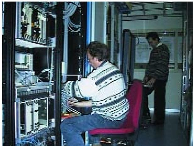
Ampliamento su un apparato DXC (Digital Cross Connect) 4/3/1.
